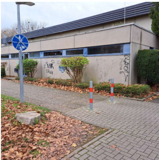
bei der Gymnasium-Sporthalle
