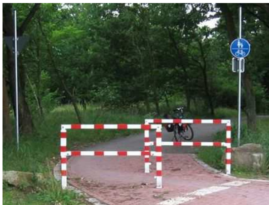
Abb. 2/3: Beispiele für Umlaufsperrn, die nicht den Anforderungen des ADFC genügen.
