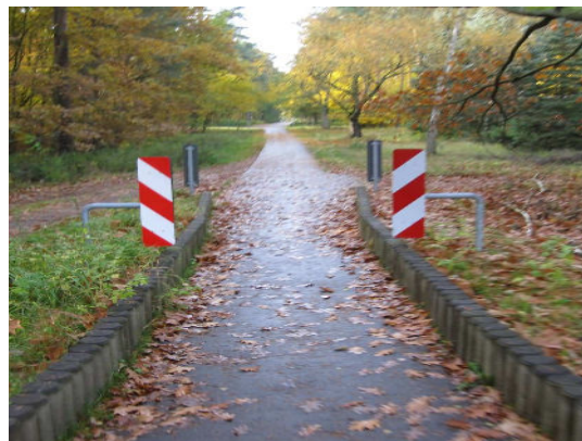
Abb. 5: Barrierefreier Ausschluss von Kraftfahrzeugen durch bauliche Verengung.
